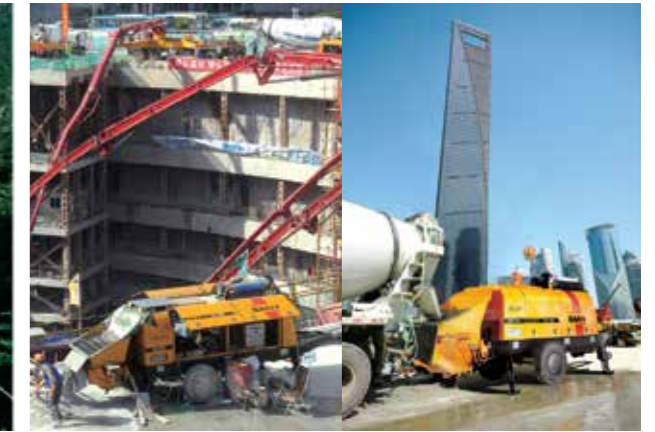
Bơm tính Sany thi công Trung tâm tài chính Thượng Hải
